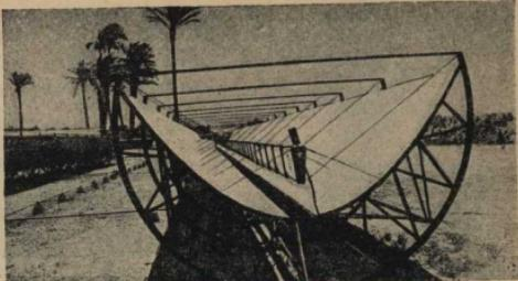
СПРАВА—СОЛНЕЧНЫЙ ДВИГАТЕЛЬ ШУМАНА: несмотря на то, что он работает вполне удовлетворительно, самая большая установка солнечного двигателя пока еще не превышает мощности 100 л. с., сла. СЛЕВА—БАБУШКА ПАРОВЫХ МАШИН—машина Ньюкомена, построенная в 1705 году. Еще в 1830 году она работала на одном из английских рудников, перевода в энергию только один фунт топлива из каждого затраченного пуда, т. е., используя всего  $2,5\%$  его полного действия.
