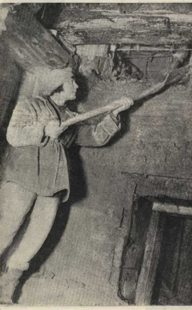
Она тщательно следит за тем, чтобы бетон хорошо утрамбовывался.
