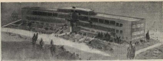
Центральный аэроклуб строится в Тушине, под Москвой.
