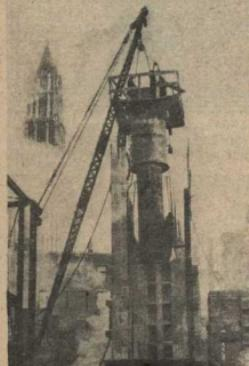
**НАЧАЛО ПОСТРОЙКИ НЕБОСКРЕБА:** здесь изображена установка кессона для фундамента будущего небоскреба. Для большей твердности фундамент должен быть залит на глубину 30-40 метров.
