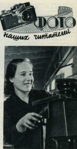
Мария Кулинова работает сборщицей на Свердловском трансформаторном заводе. Молодая производственница ежедневно перерабатывает тонны отличного качества. Сейчас Мария монтирует трансформаторы, которые будут отправлены на целинные земли.
