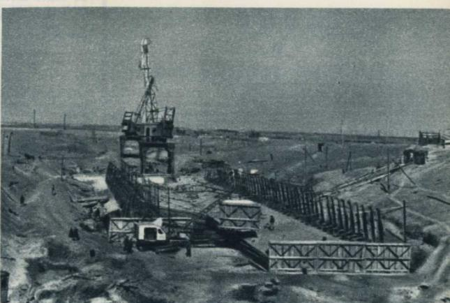
Разгрузка и установка на дно шлюза арматурных ферм производится с помощью порталного крана.
