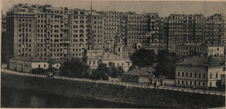
В Москве, на Берсеневской набережной, заканчивается стройка нового дома правительства.
