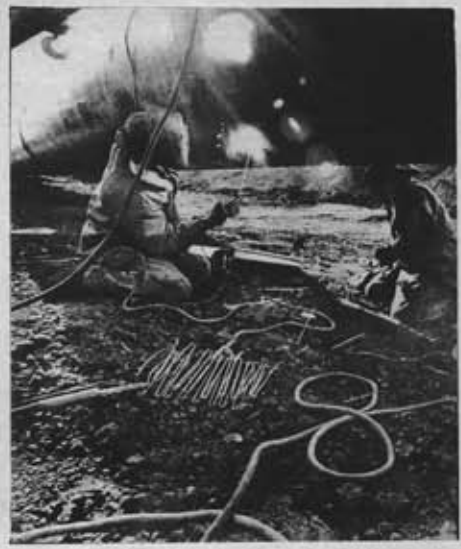
ПРЕЖДЕ ЧЕМ СВАРИТЬ ТРУБЫ, ИХ ТЩАТЕЛЬНО ЦЕНТРУЮТ.
