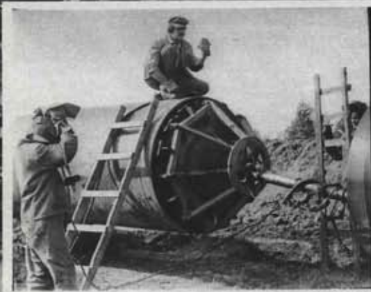
ПРЕЖДЕ ЧЕМ СВАРИТЬ ТРУБЫ, ИХ ТЩАТЕЛЬНО ЦЕНТРУЮТ.
