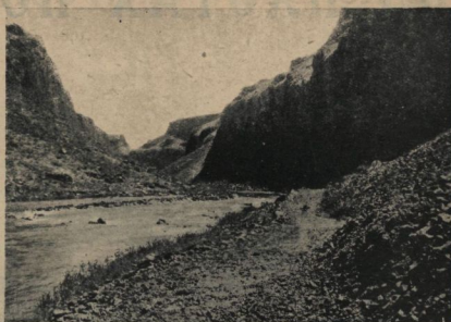
Ущелье реки Ушае в районе строящегося курорта Арани. Баавальто-вые пороги.
