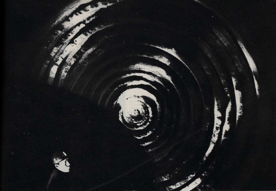
След проходческого комбайна на пласту.
