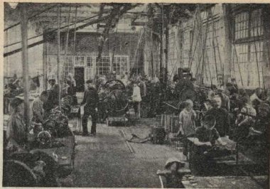
ФАБЗАВУЧ КОЛОМЕНСКОГО ЗАВОДА: слесарно-механическая мастерская.
