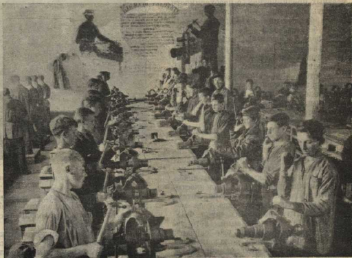
НАВЕРХУ: Слесарный цех фабзавуча М. В.-Б. ж. д.
