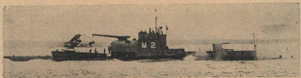
Новая английская подводная лодка - авиоматка. Перед погружением в воду самолет помещается в водонепроницаемую камеру
