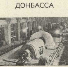
Общий вид восстановленной пятой турбины на Энегетической электростанции
