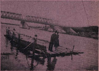
Мост над рекой («Зеленый шум»)
