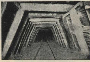
Деревянные балки, служащие крепями в шахте.
