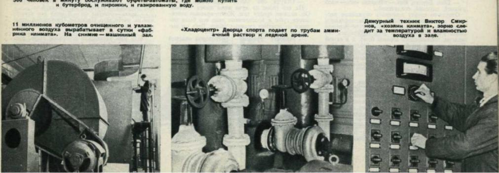
11 миллионов кубометров очищенного и увлажненного воздухарабатывает в сутки «фабрика климата». На снимке — машинный зал.
