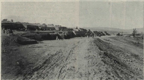
Разработка площадки под ст. Западно-Сортировочная
