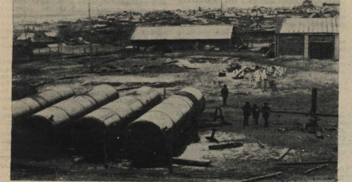
На территории строительства. Мощные котлы для котельного цеха
