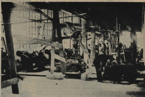
Остранивающийся механический цех тракторострой. Сборка и установка новых американских станков
